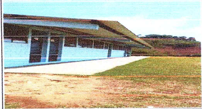
FOTO 2. REPARACION DE MURO PERIMETRAL
